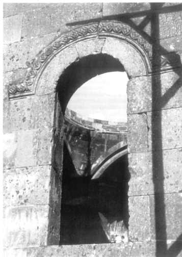
4. Eglise de Thalich (661-682) : frise décorative autour d'une fenêtre à travers laquelle on aperçoit une des quatre trompes de la coupole centrale (cliché A. Mekhitarian).
