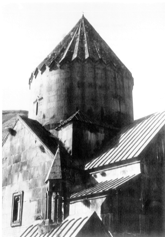
12. Eglise de Bdzni (1031) : coupole surmontée d'un toit en parapluie (cliché A. Mekhitarian).
